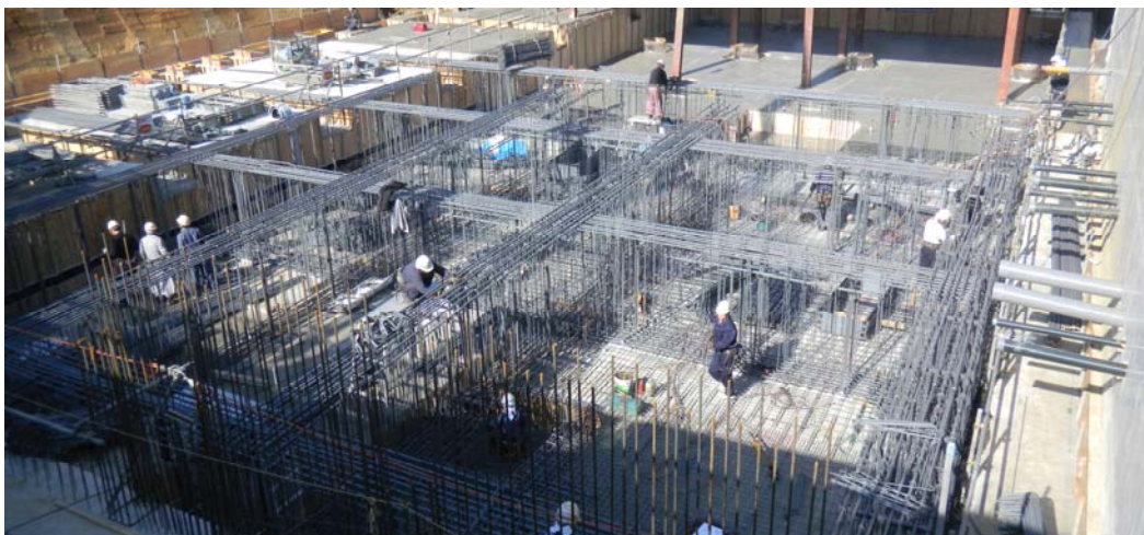
写真-1 鉄筋施工例
