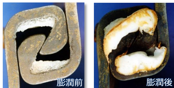
図1 矢板継手部の膨潤状態
