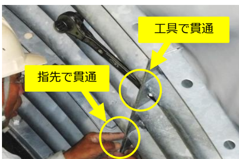
図3 ボルト穴の処理
