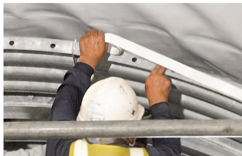
図2 貼付け施工状況
