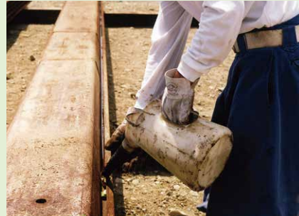
写真-9 流し込み
