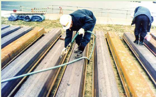
写真-3 鋼矢板の平置きとエアブロー作業
