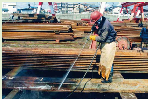
写真-13 ウォータージェットによる清掃作業
