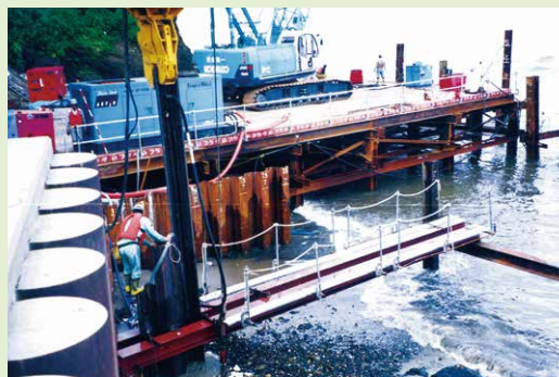
写真-12 打込みの例
