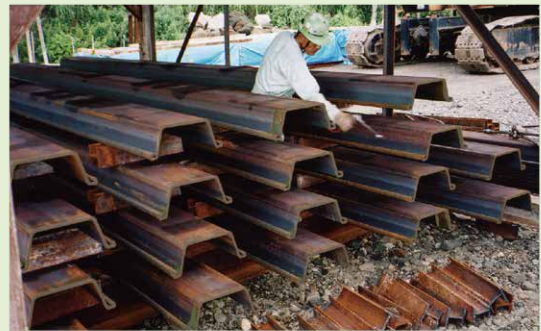
写真-4 鋼矢板の重ね置きとエアブロー作業
