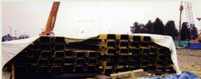
写真-10 養生(硬化)の例
