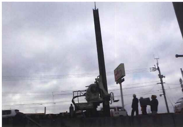
鋼矢板引抜き状況
