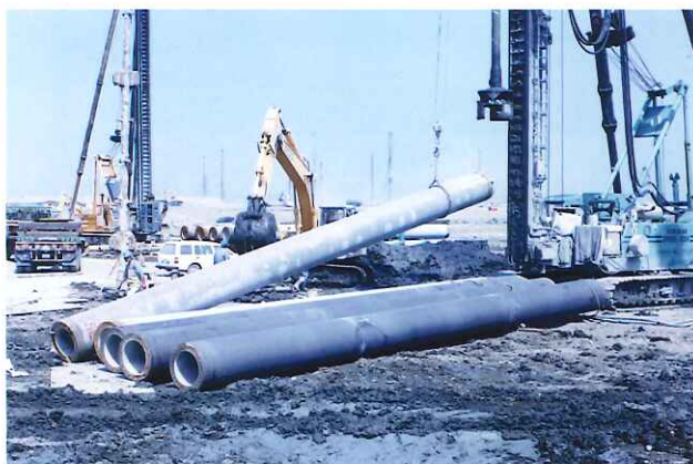
負の摩擦力対策杭施工状況
